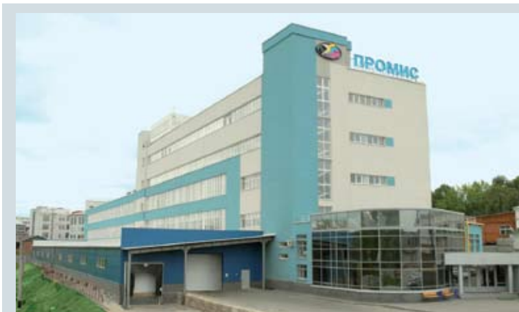
Офис и производство компании «ПРОМИС» находятся в собственном отдельном здании с удобными подъездными путями
